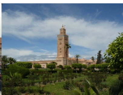
Kutúbíjská mešita (foto autoři)
